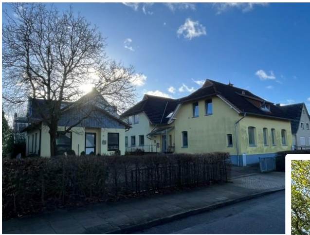
Vor- und nach der Renovierung
